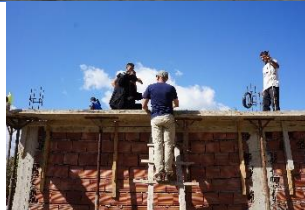
Inspectie bij een bouwproject. →
